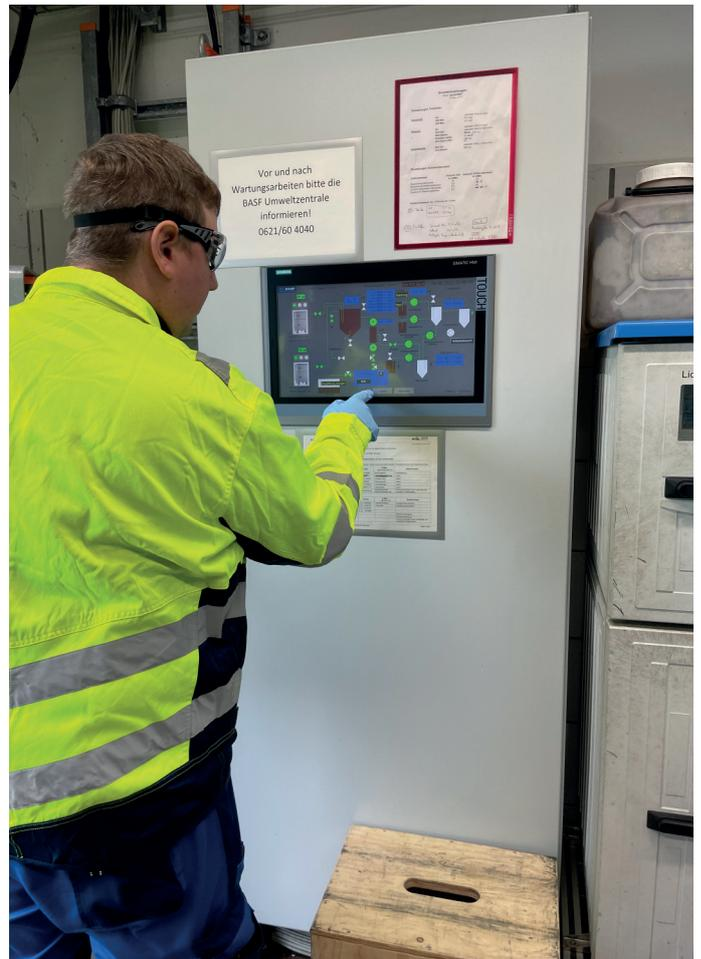
Bedienung Prozessleitsystem, zum Beispiel Ausschalten einer Pumpe um Arbeiten an der Anlage ausführen zu können
