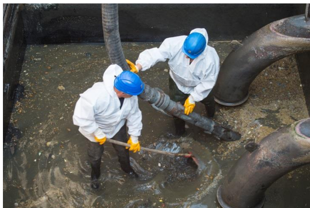
Mitarbeiter des Betriebs bei der Pumpensumpfreinigung
