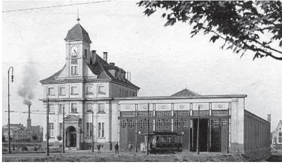
→ Das ursprüngliche Straßenbahndepot um 1910 vor seiner Erweiterung. Links das Verwaltungsgebäude im Urzustand mit quadratischem Grundriss.
