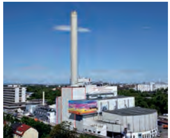
→ Das geplante neue Kesselhaus (rote Kontur) neben der Bahnlinie, das im Zuge des Projektes IGNIS entsteht.
