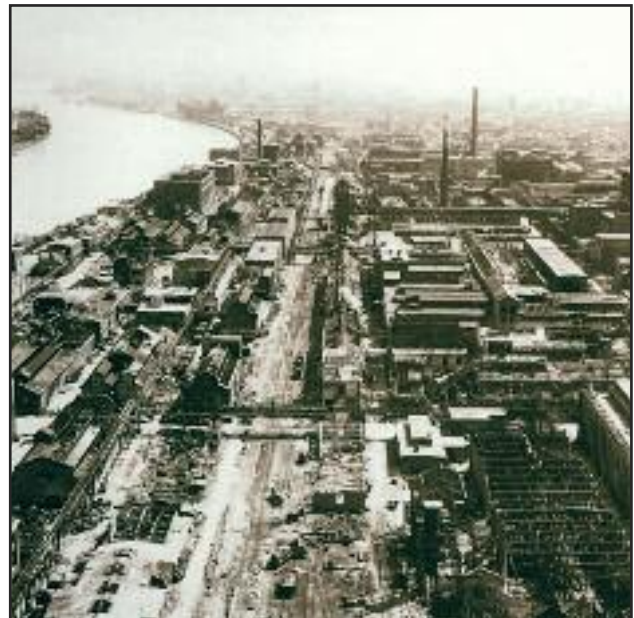
Durch Kriegseinwirkung zerstörte Industrieanlage in Ludwigshafen
