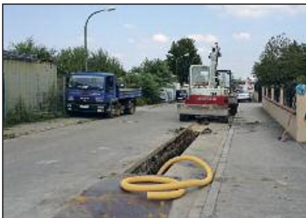
Bodenluftabsaugleitungen werden verlegt
