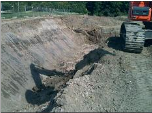
Städtische Baumaßnahme – zuvor überprüft der Bereich Umwelt, ob für die Fläche ein Altlastverdacht vorliegt
