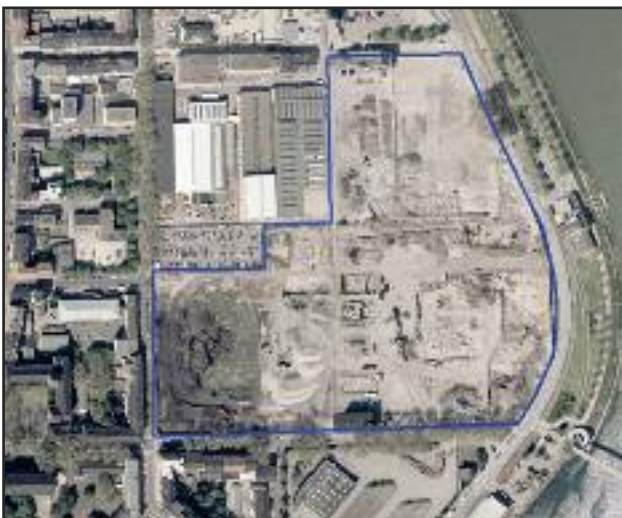
Sanierungsmaßnahme auf dem Gelände der ehemaligen Halberger Hütte am Rheinufer Süd
