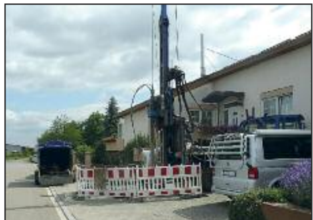
Bohrarbeiten zur Herstellung der Bodenluftabsaugbrunnen
