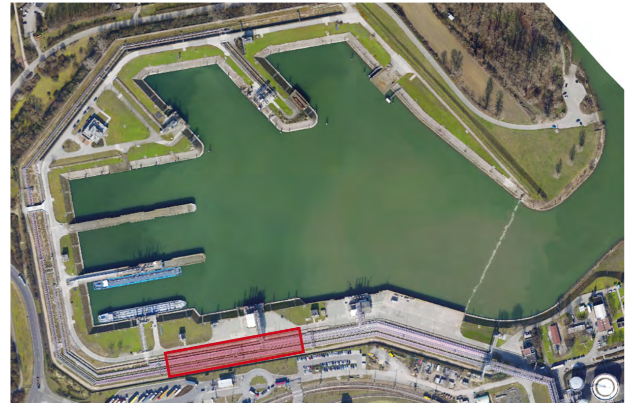
Hauptschadensbereich (Luftbild aus LUMIS)
