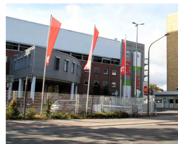
Gebäude TWL mit Batteriespeicher (Foto: TWL)
