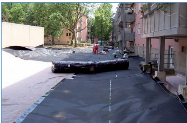
Verlegung der Kunststoffdichtungsbahn
