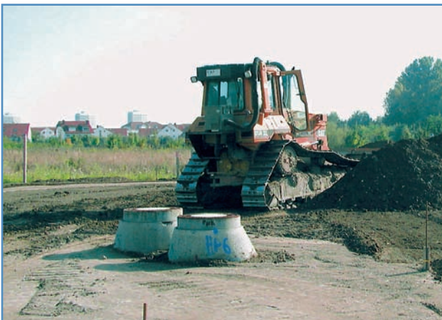
Städtische Straßenbaumaßnahme – zuvor überprüft der Bereich Umwelt, ob für die Fläche ein Altlastverdacht vorliegt
