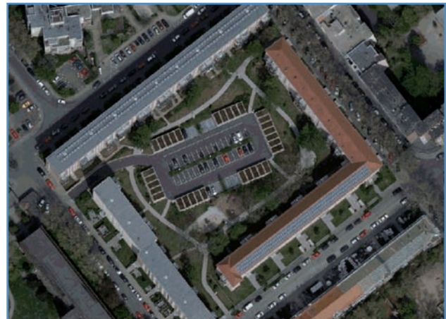
Luftbildaufnahme des sanierten Blockinnenbereichs (2008)
