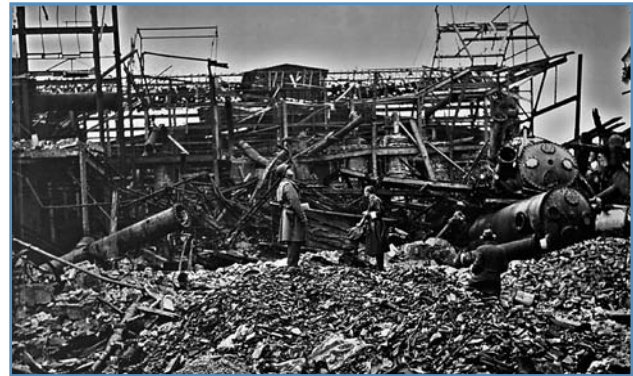
Durch Kriegseinwirkung zerstörte Industrieanlage in Ludwigshafen
