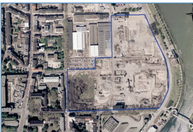
Sanierungsmaßnahme auf dem Gelände der ehemaligen Halberger Hütte am Rheinufer Süd
