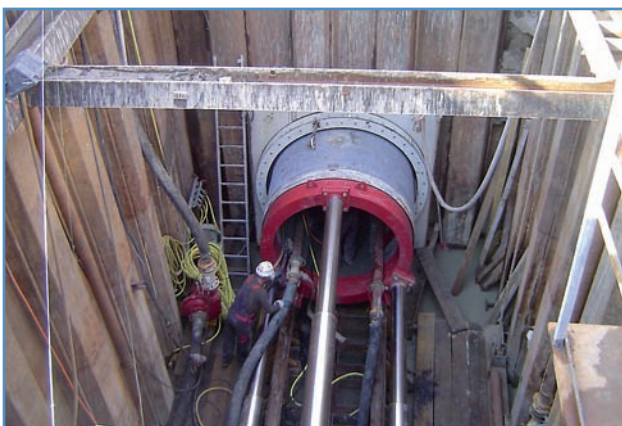
Kanalverlegung im unterirdischen Rohrvortrieb in Oggersheim
