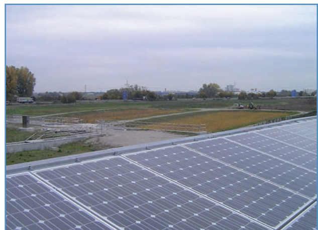
Regenwasseranlage Ruchheim. Im Vordergrund: Die neue Photovoltaikanlage auf dem Pumpwerksdach
