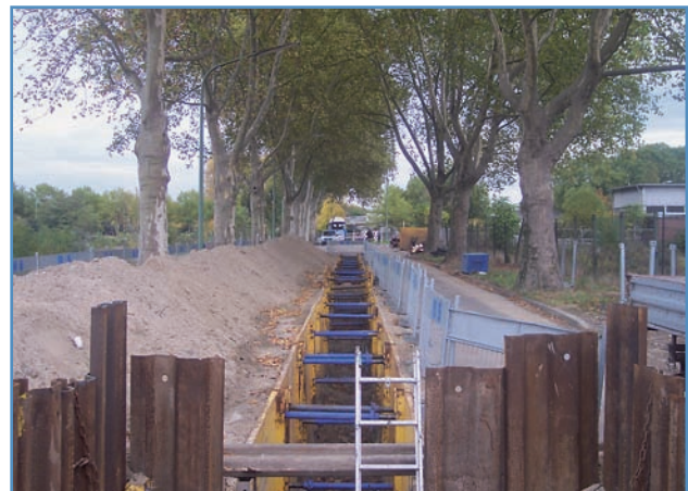
Offene Kanalverlegung
