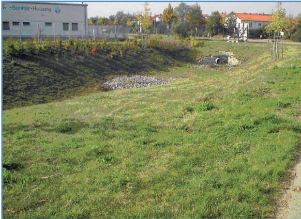
Regenwasser aus dem Trennsystem muss nicht in die Kläranlage: Versickerungsanlage am Unteren Grasweg
