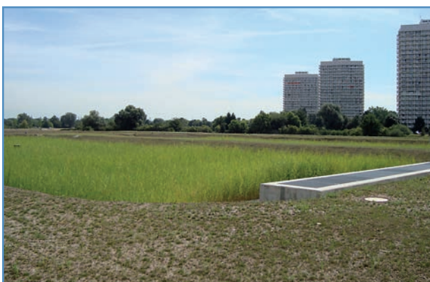
Regenwasseranlage Froschlache: Retentionsfilterbecken
