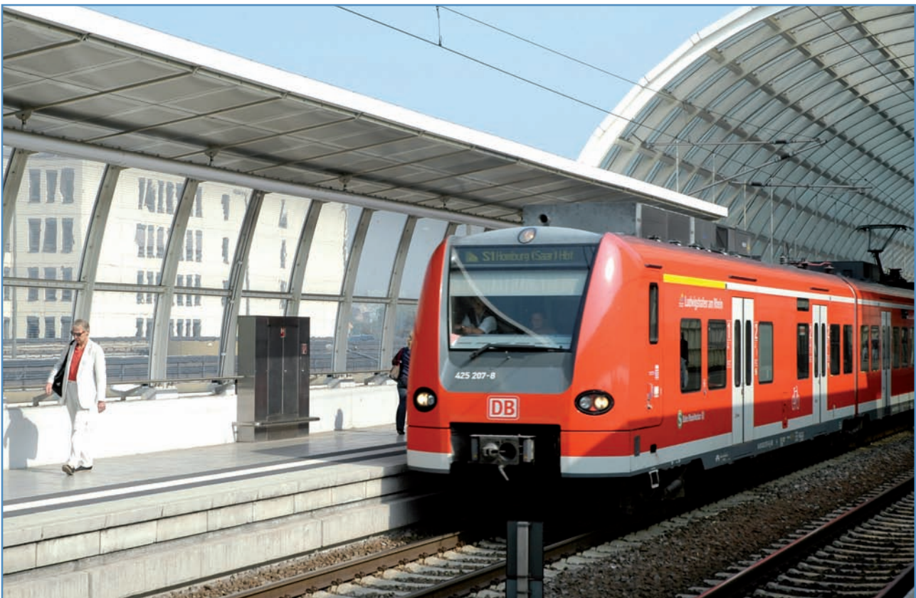
Bahnhof Ludwigshafen Mitte, Maßnahmen Lärmvorsorge
