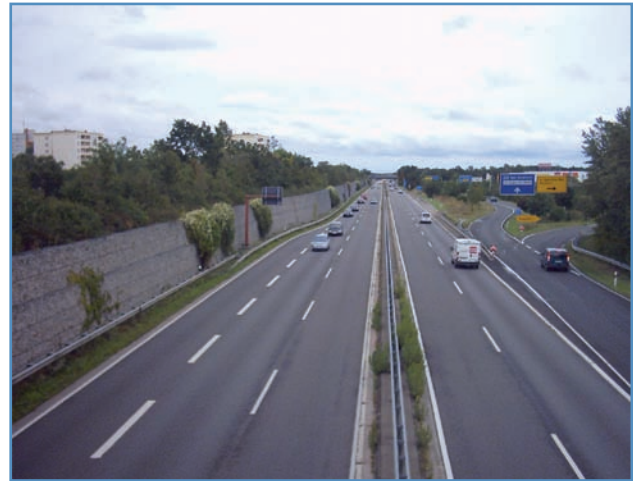
Gabionenwand als Lärmschutz an der B9
