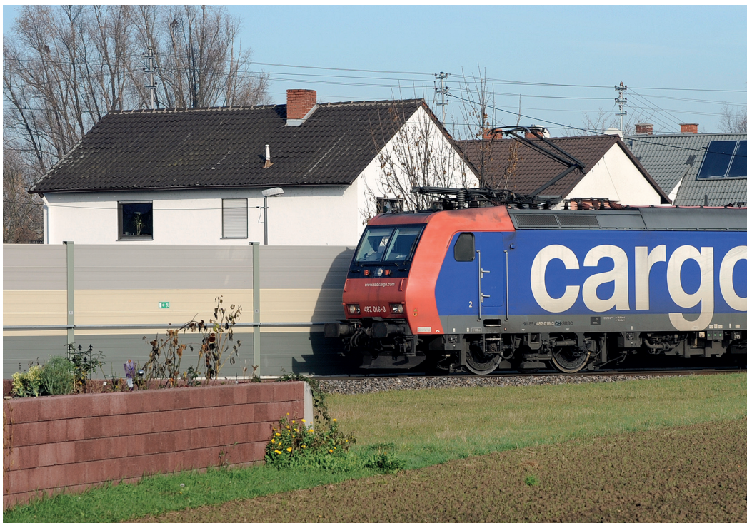
Lärmschutz entlang der Bahnlinie zum Kombi- Verkehrsterminal im Bereich Im Zinkig in Edigheim
