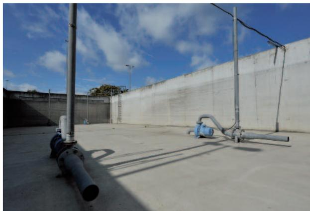
Regenüberlaufbecken mit Strahlpumpen
