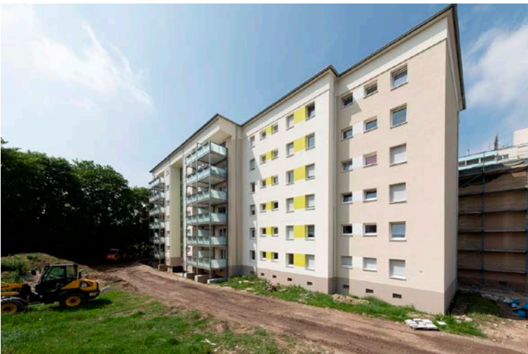
Abbildung 36: Modernisierung eines Wohnquartiers an der Karlsbader Straße in der Gar- tenstadt
