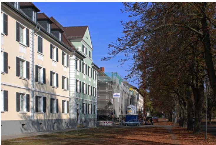
Abbildung 5: Links die sanierten Hohenzollernhöfe und rechts die aktuelle Modernisierung in der Fichtestraße in Friesenheim
