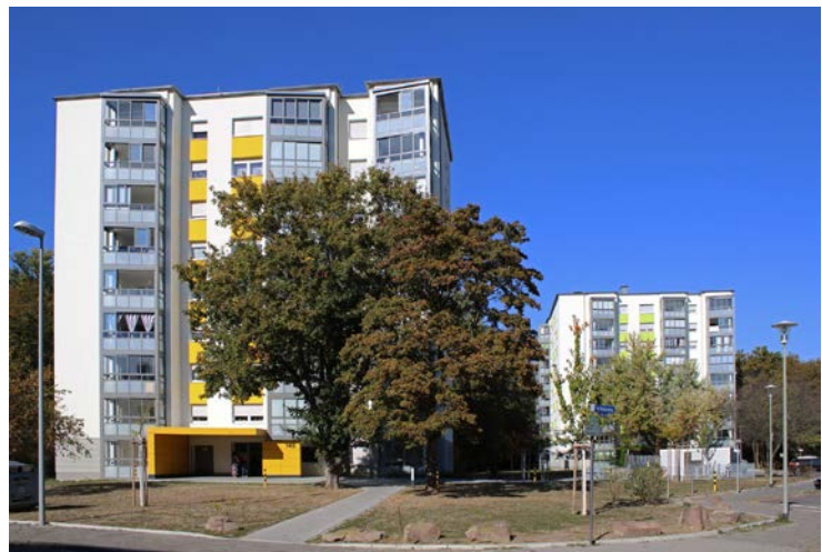
Abbildung 9: Sanierte Wohnhochhäuser im Weidenschlag in Oggersheim
