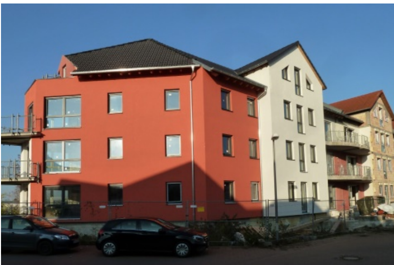
Abbildung 33: Wiederbelebung und Fertigstel- lung der Bauruine am Erfurter Ring in Ruchheim
