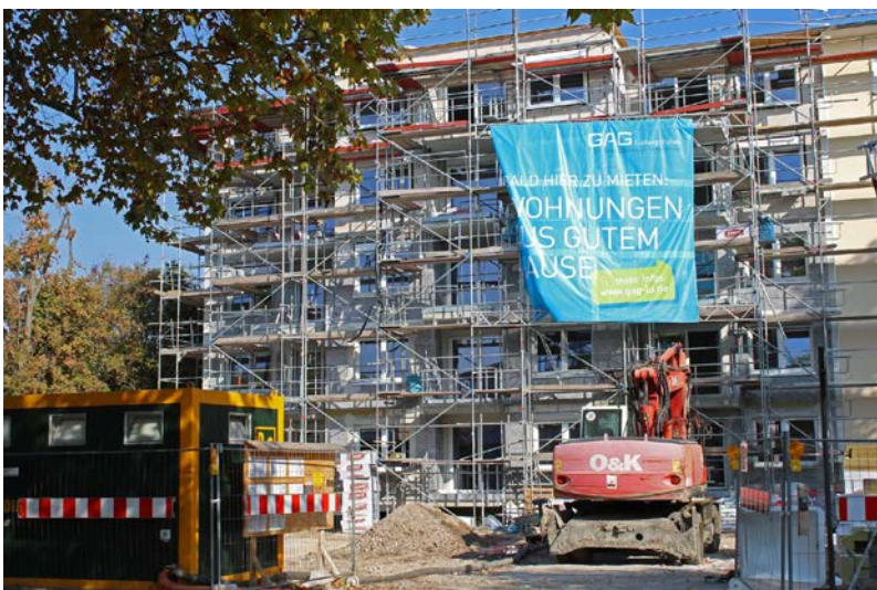
Abbildung 26: Neubauprojekt im geförderten Wohnungsbau in der Brunhildenstraße im Stadtteil West
