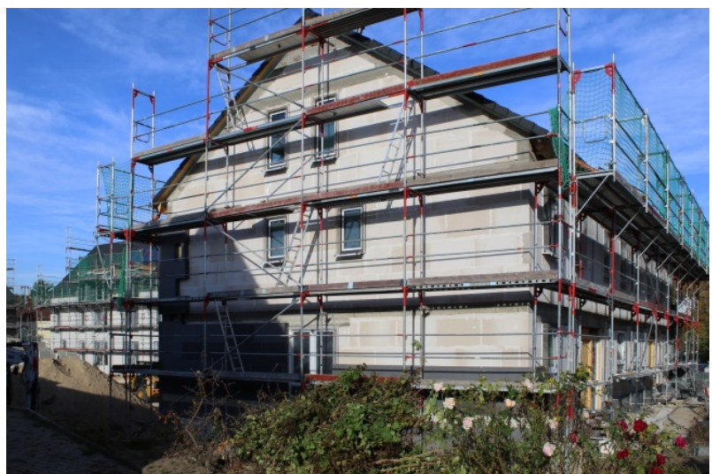
Abbildung 38: Neue Ersatzbebauung am Ligustergang in der Gartenstadt
