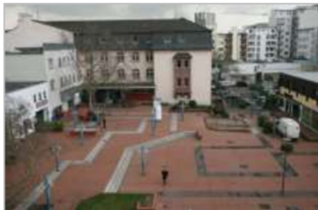
Bürgerhof – vor Umbau Quelle: http://www.morgenweb.de/ vom 20.10.2014; Foto: Thomas Rittelmann
