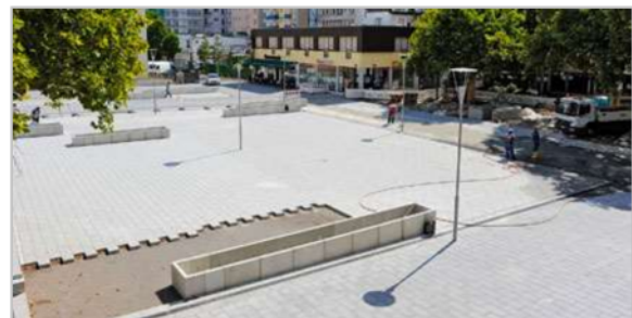
Bürgerhof – nach dem Umbau Quelle: Stadt Ludwigshafen
