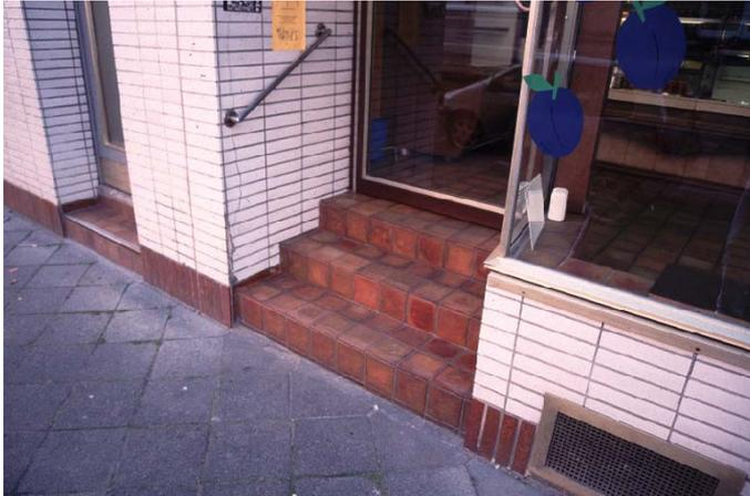
*Ebenso wie dieses Beispiel sind fast alle Ladengeschäfte im Sanierungsgebiet West aufgrund der höher liegenden Erdgeschosszone nicht barrierefrei zugänglich.*
