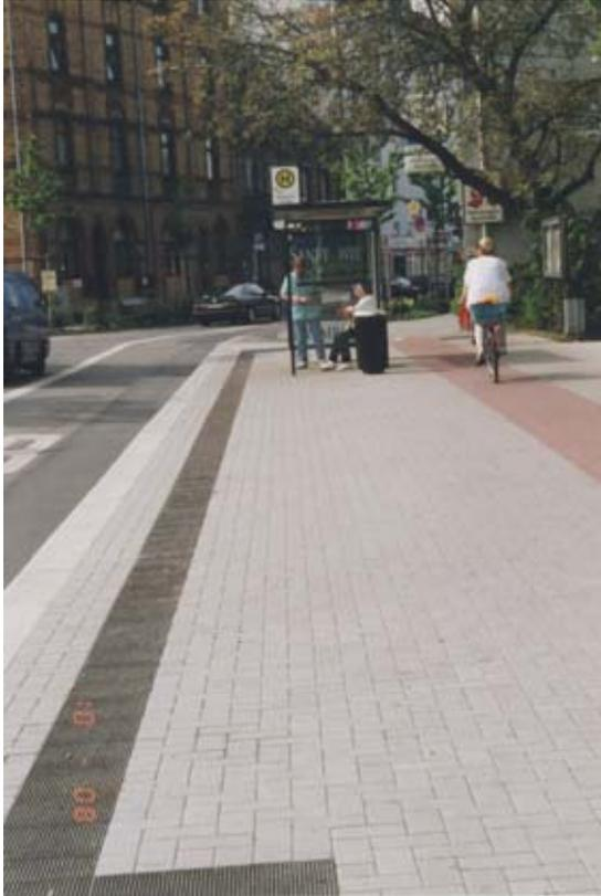
*Die Bus-Haltestelle „Rohrlachstraße“ (vor dem Bunker) verfügt über Blindenleitstreifen mit Markierung der Einstiegsstelle.*
