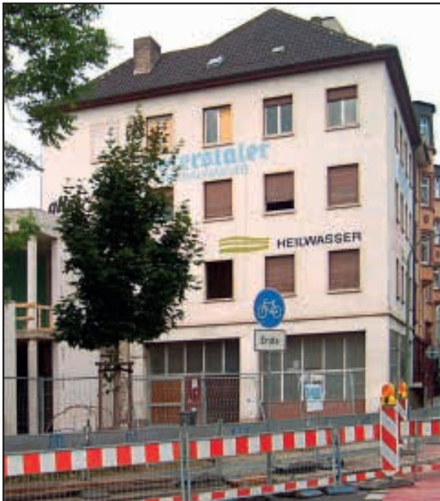
Bürgermeister-Grünzweig-Straße 61 vor der Modernisierung
