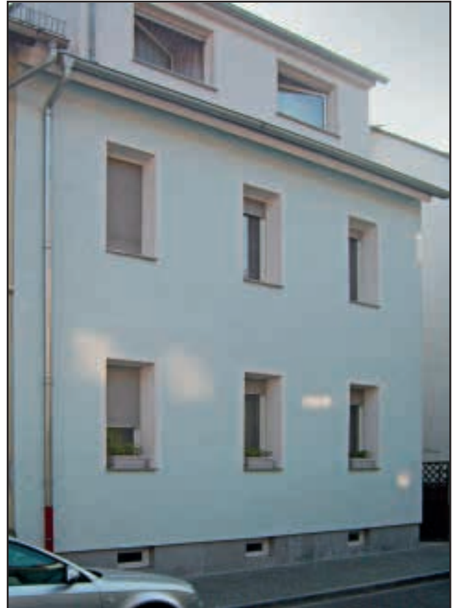
Haus in der Alberichstraße nach der Modernisierung
