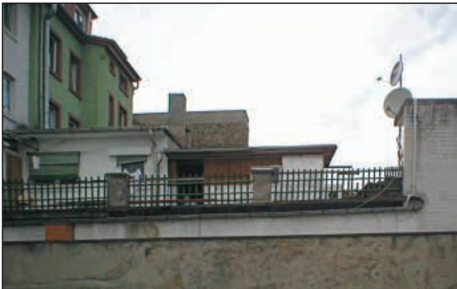
Rückgebäude Frankenthaler Straße 76 mit Überbauung
