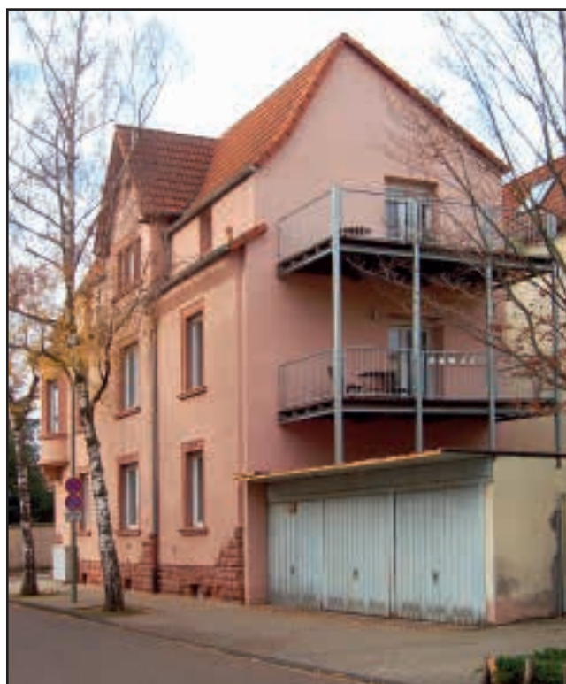
Ansicht des Hauses nach Balkonanbau
