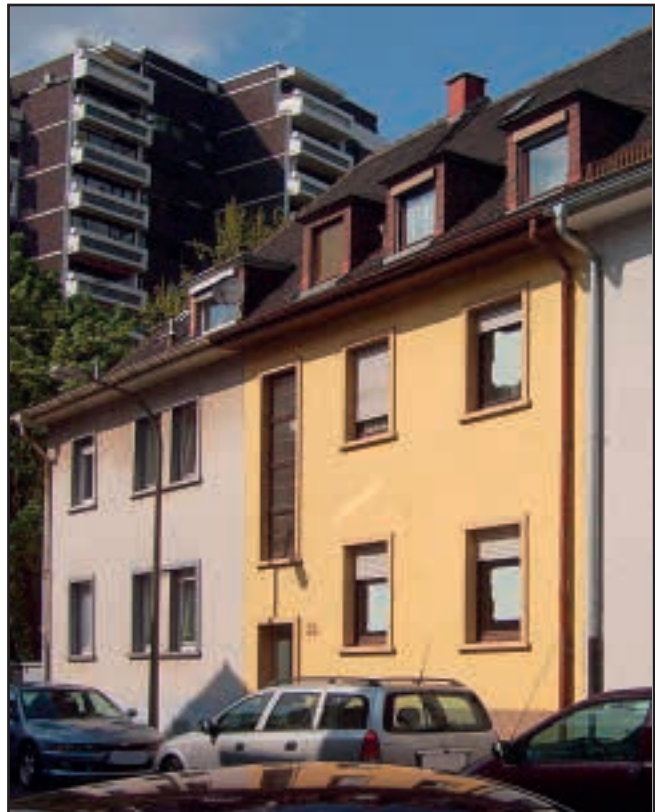
Alberichstraße 14 vor der Modernisierung
