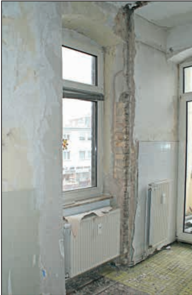
Beispielwohnung Valentin-Bauer-Straße 32 während der Modernisierung
