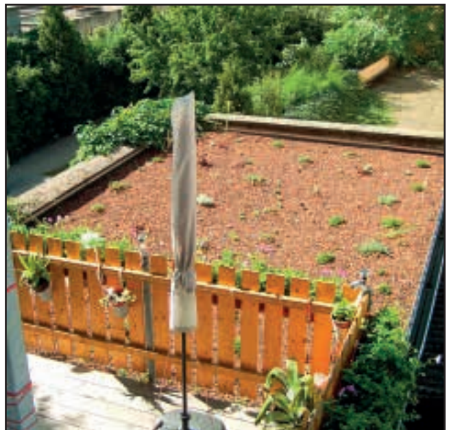
Rückgebäudedach nach der Begrünung
