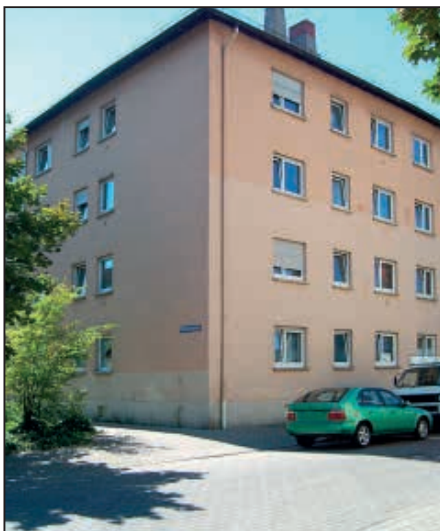
Volkerstraße 3 vor der Modernisierung
