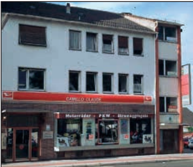
Bürgermeister-Grünzweig-Straße 67 Straßenansicht vor der Modernisierung
