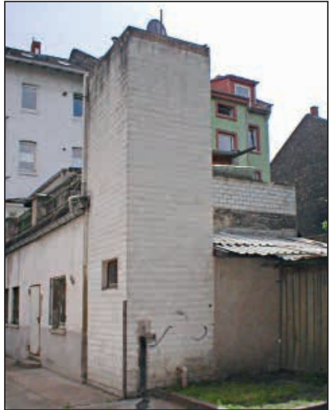
Rückgebäude Frankenthaler Straße 76 mit heute nicht mehr zeitgemäßem Behindertenaufzug
