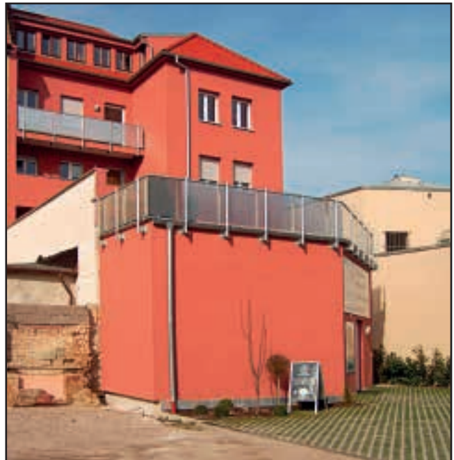
Bürgermeister-Grünzweig-Straße 61 Rückansicht vom Lagerplatzweg aus
