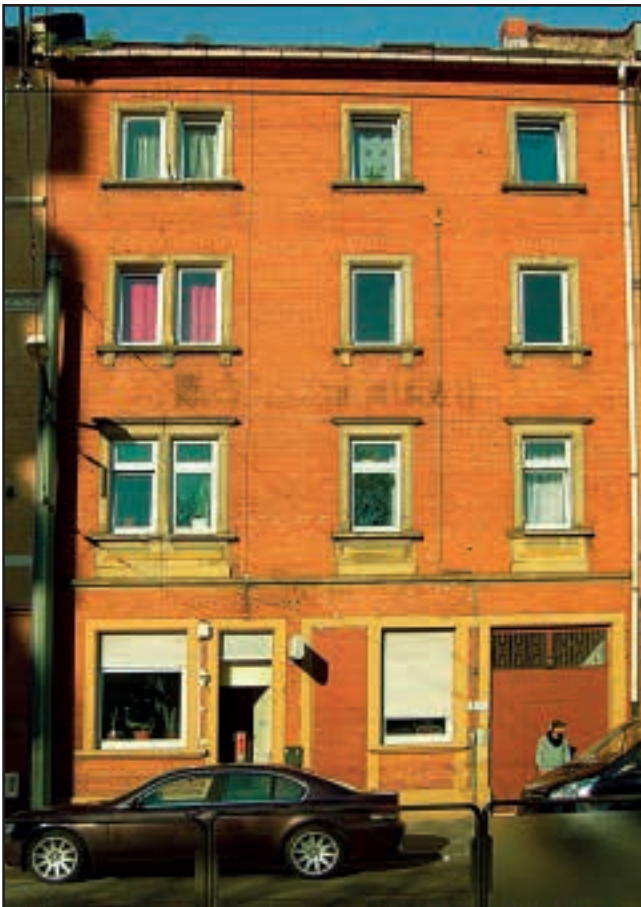
Frankenthaler Straße 76 während der Modernisierung
