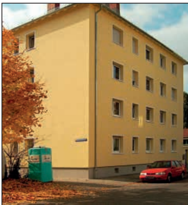
Volkerstraße 3 nach der Modernisierung
