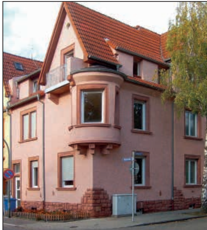
Walkürenstraße 4 nach der Modernisierung
