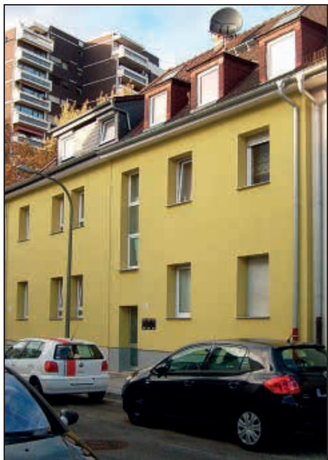
Alberichstraße 14 nach der Modernisierung
