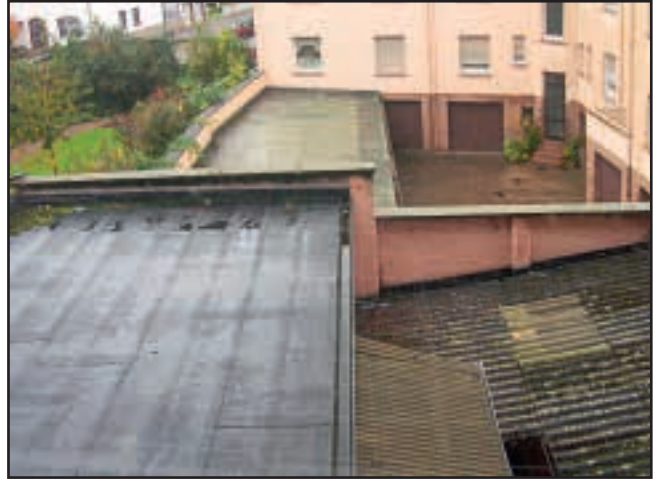
Rückgebäudedach Valentin-Bauer-Straße 16 vor der Begrünung
