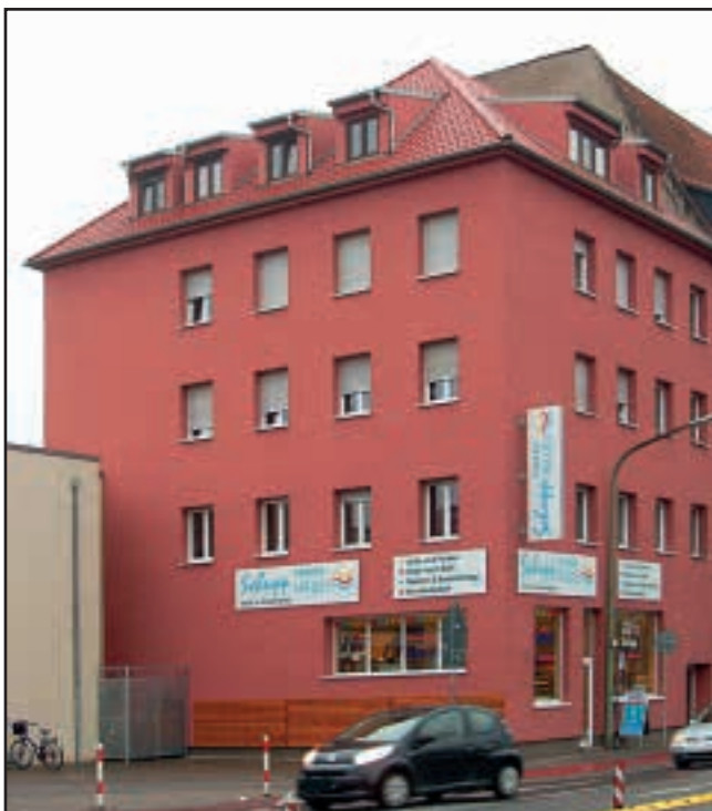
Bürgermeister-Grünzweig-Straße 61 nach der Modernisierung
