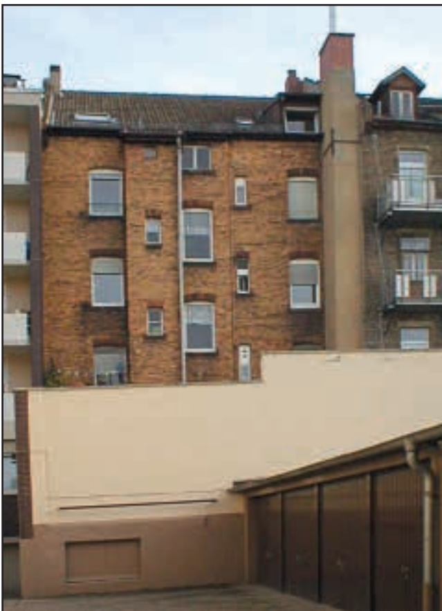
Rückansicht Valentin-Bauer-Straße 16 vor der Modernisierung
