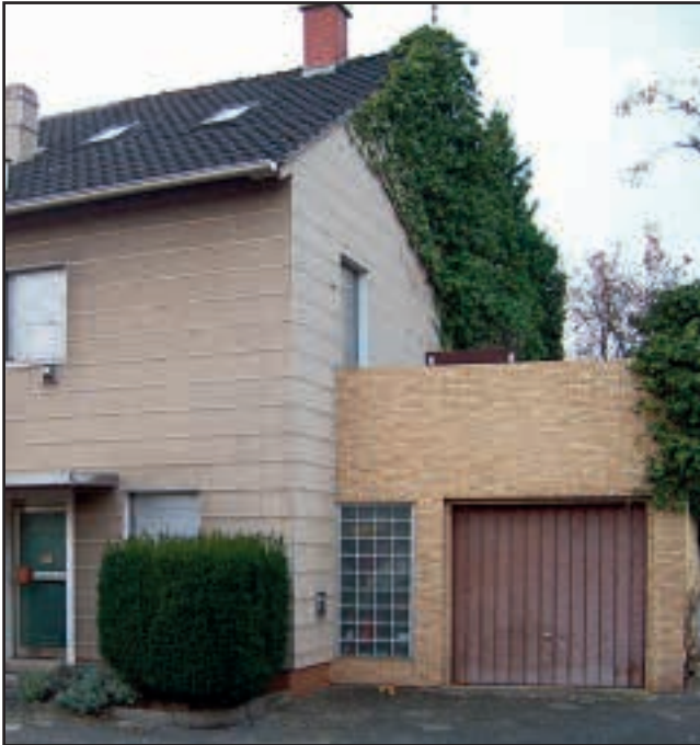
Straßenansicht vor und nach der Modernisierung
