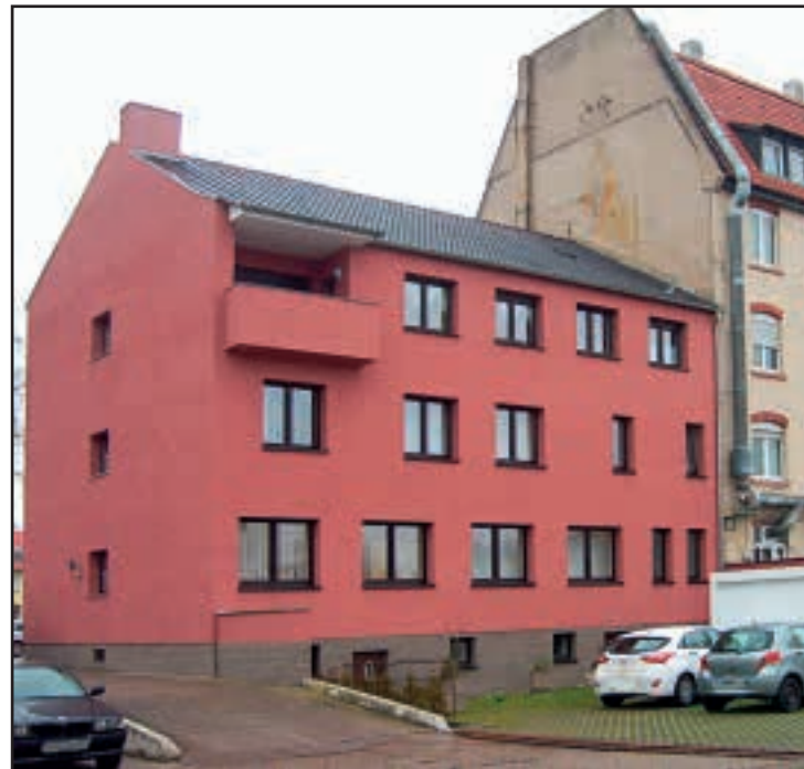
Bürgermeister-Grünzweig-Straße 67 Rückansicht nach der Modernisierung
