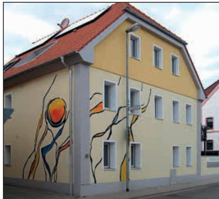
„Pfälzer Lodge“ in Eppstein
