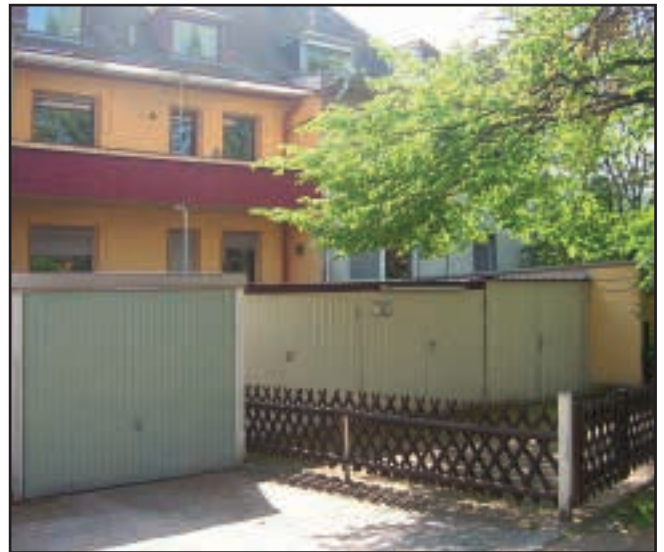
Versiegelter Hof Alberichstraße 14 mit Dreifachgarage vorher
