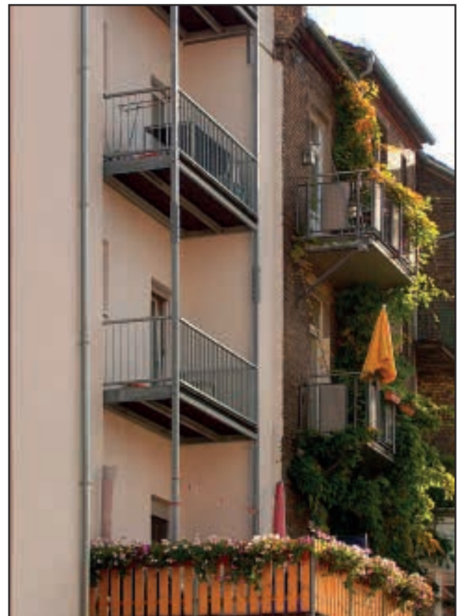
Gedämmte Rückfassade Valentin-Bauer-Straße mit Balkonanlage und begrünter Terrasse auf dem Dach des Rückgebäudes
