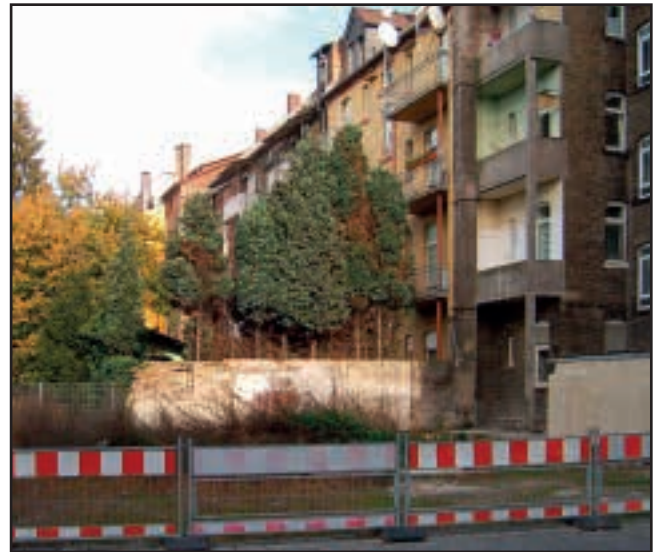
Sieg Lindenstraße 28 nach der Abbruchmaßnahme (Neugestaltung erfolgt noch)
