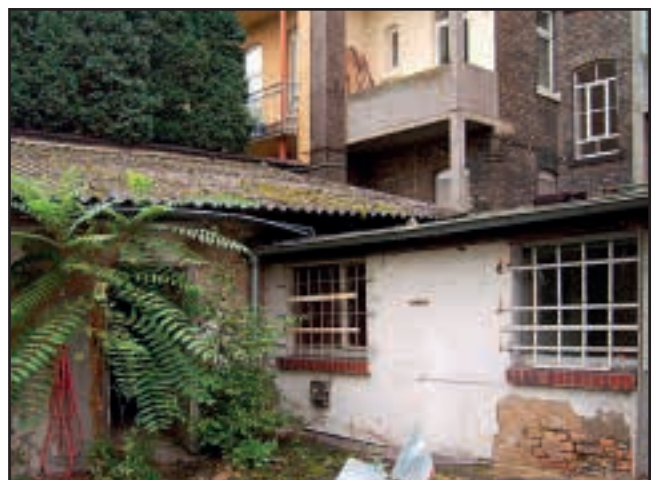
Baracken des ehemaligen Getränkehandels Sieglindenstraße 28
