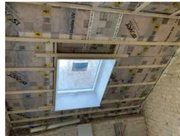
→ Modernisierung Frankenthaler Straße 112
