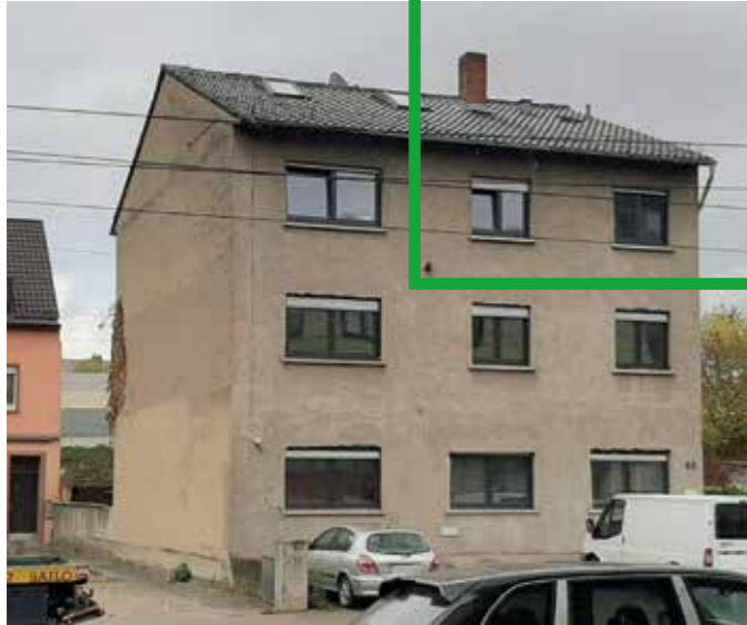
→ Frankenthaler Straße 92 vor der Modernisierung
