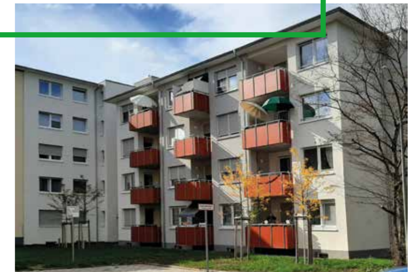
→ Neubau Brunhildenstraße 10 und 12
