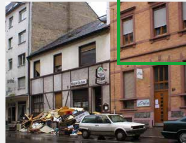
→ Früheres Gebäude Valentin-Bauer-Straße 19 vor dem Abbruch
