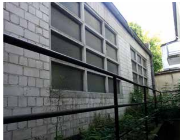
→ Rückgebäude vor dem Abbruch
