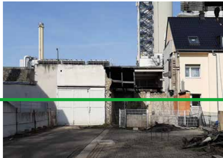
→ Derzeitige Werkshalle von der Frankenthaler Straße aus
