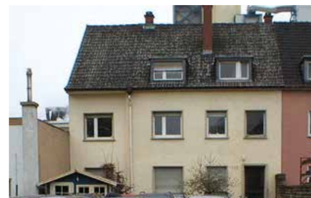
→ Frankenthaler Straße 112 vor und nach der Modernisierung
