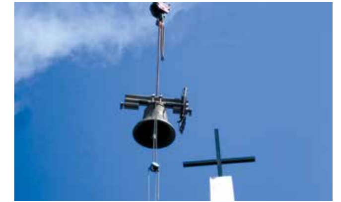
→ Glocken werden abmontiert
