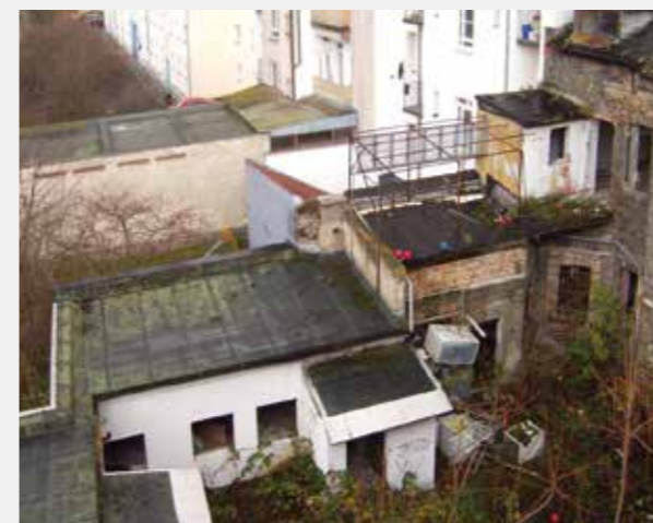
→ Hof Valentin-Bauer-Straße 19 vor dem Abbruch
