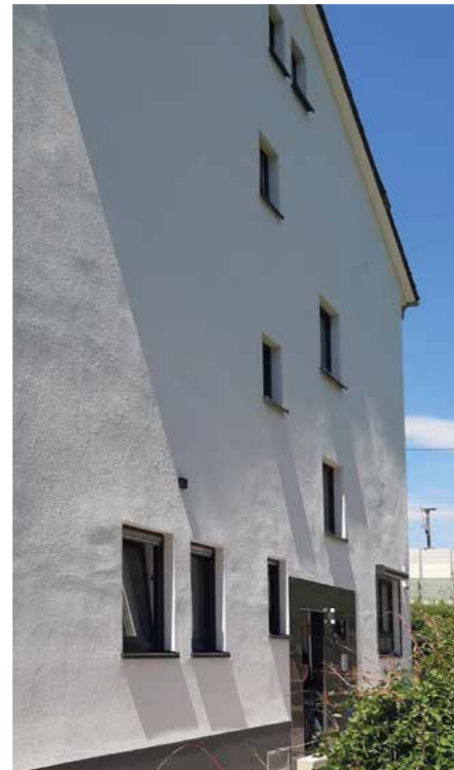
→ Frankenthaler Straße 92 nach der Modernisierung
