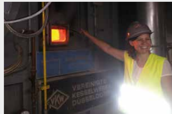
→ Vor dem Feuerraum
