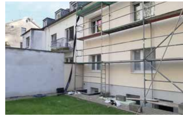
→ Freifläche nach Rückgebäudeabbruch
