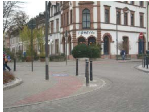
Abb. 3.19 Aufpflasterung als verkehrsberuhigende Maßnahme in der Rohrlach-/Gräfenaustraße
