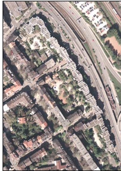
Abb. 3.6 Lärmschutzbebauung an der Dessauer Straße (Luftbild)
