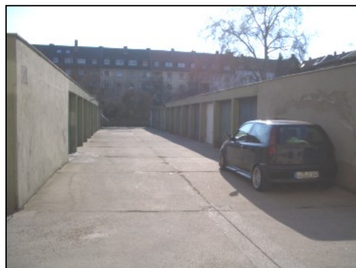
Abb. 3.22 Garagenhof in der Blücherstraße
