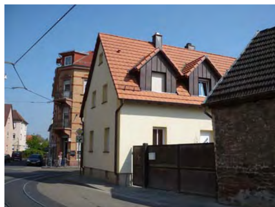
Abbildung 15: Saniertes Objekt Ecke Kreuzstraße / Luitpoldstraße
