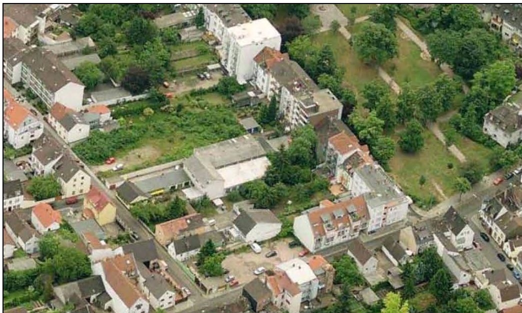
Abbildung 33: Bereich südlich der Hagellochstraße, Bebauungssituation vor Errichtung der Reihenhäuser an der Kreuzstraße
