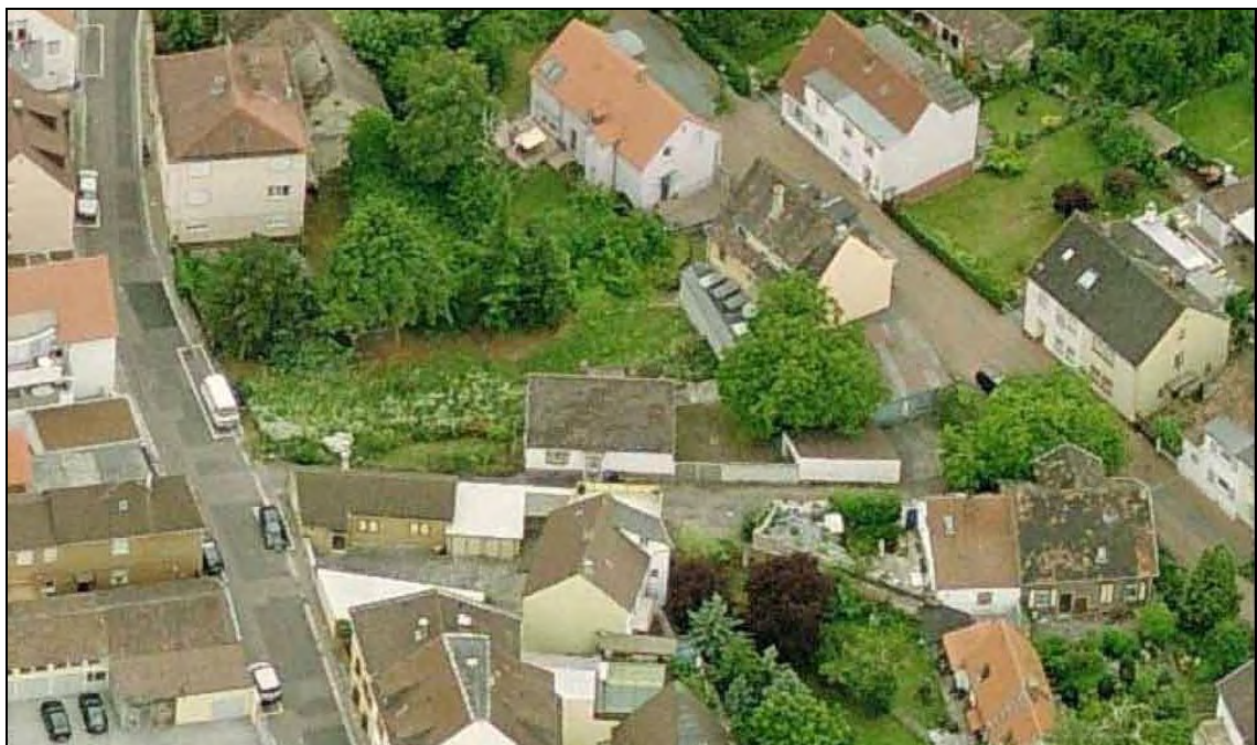
Abbildung 25: Bauernwiesenstraße 28 – 36: Aktuelle Bebauungssituation
