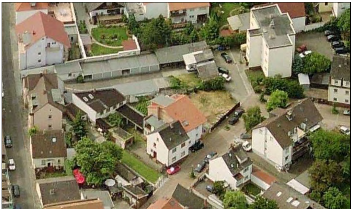
Abbildung 27: Brechloch/Friedrich-Profit-Straße: Aktuelle Bebauungssituation
